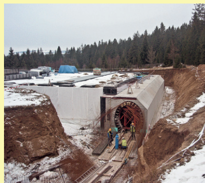
60m tunel v otevřeném výkopu - Šumava
