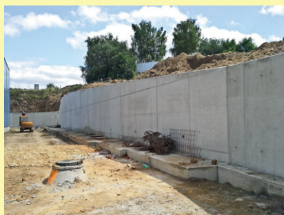
Hala Swoboda Jihlava - opěrná zeď
