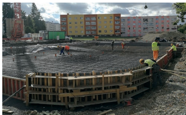
Armování a bednění základové desky
