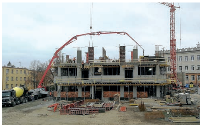
Betonáž druhé části stropu 2. nadzemního podlaží
