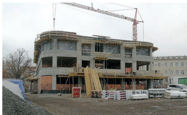
Bednění oblé atiky a zimní opatření po betonáži
