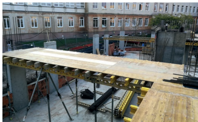
Bednění průvlaků 1. nadzemního podlaží
