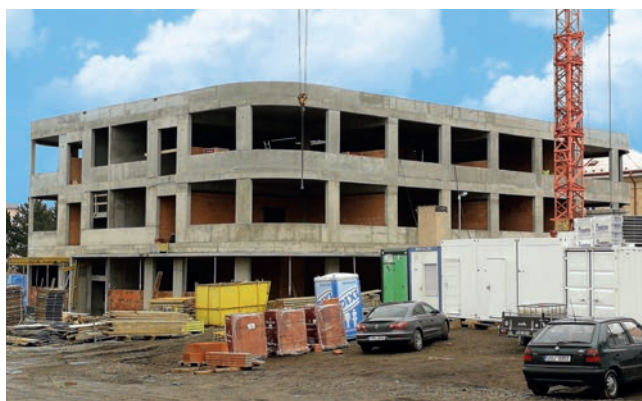
Dokončená hrubá stavba
